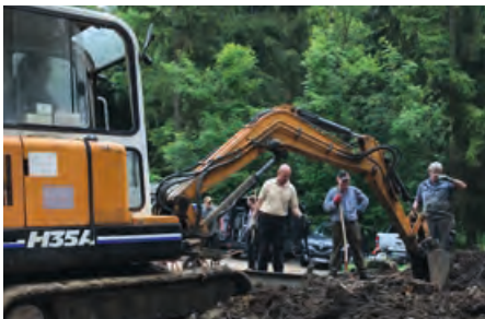
Helfertag: Entfernen des Wurzelwerks
