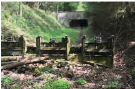
100m Bahn vor Sanierung
